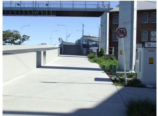
(d) Go-Between Bridge (footpath)
